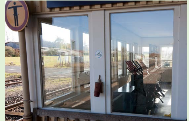
Mechanisches Stellwerk in Wallenrod
