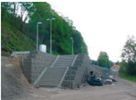
Treppenaufgang zum neuen Bahnsteig in Herzhausen Foto: Eginhard Wichmann
