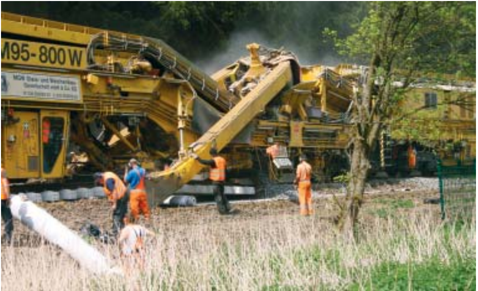
Das Herzstück des Bettungs-Reinigungszugs: Mit einer Schaufelkette wird der Altschotter unter dem Gleis entfernt und über Förderbänder zur Reinigungseinheit transportiert. Der gereinigte Schotter wird mit neuem gemischt und wieder unter die Schwellen eingebaut. 12. Mai 2015
