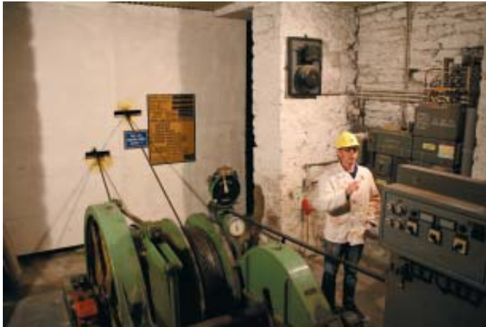
Die Fördermaschine gehört zu den Grossobjekten im "Tiefen Stollen" unter dem Weilburger Schlossplatz
