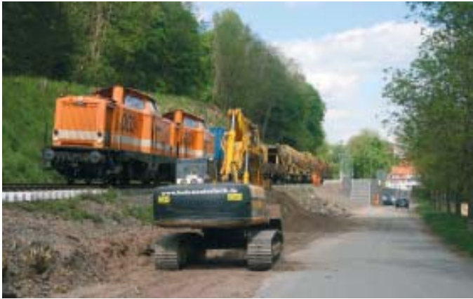
Locon 207 + Locon 206 bringen mit vier Siloeinheiten MFS-100 den unbrauchbaren Alt-schotter zur Entladestation am neuen Haltepunkt bei Herzhausen. Im Hintergrund ist der Zugang zum neuen Bahnsteig zu sehen. 13. Mai 2015. Foto: Jürgen Schmied
