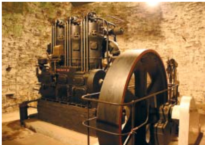
Solche Motoren waren auf Schiffen zu finden oder wurden - wie dieser - zur Stromerzeugung eingesetzt. Dieses Exemplar befand sich in einer Weilburger Mühle und sorgte für Strom bei Hochwasser und Eisgang
