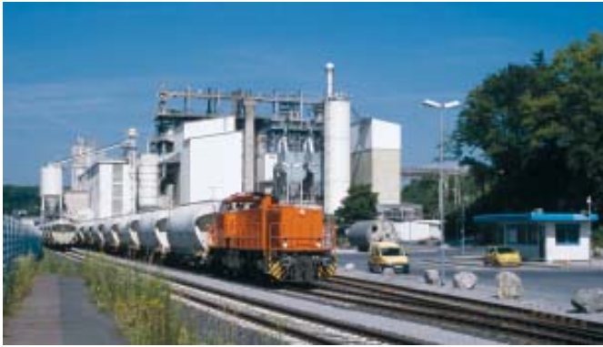
Eine Lok der BASF-Werksbahn übernimmt am 26.06.2010 gerade einen beladenen Kalkzug im Kalkwerk Steeden und wird ihn nach Ludwigshafen bringen. Foto: Andreas Christopher
