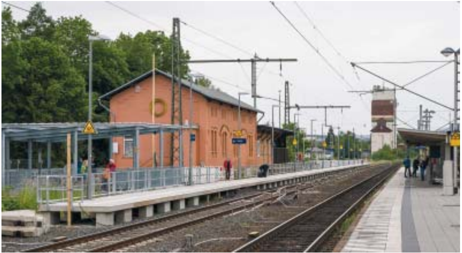
Um die Menschenmassen bei Ankunft oder Abfahrt der langen RE-Züge nicht durch den Fußgängertunnel leiten zu müssen, errichtete man auf der Westseite des Bahnhofs an dem Überholgleis einen Behelfsbahnsteig von 240 Metern Länge. Foto: Dr. Heribert Menzel
