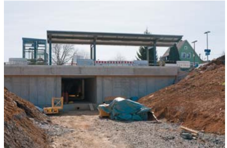
Mit dem neuen Durchstich der Bahnhofsunterführung verkürzt sich für viele Fahrgäste der Fußweg zum Bahnhof
