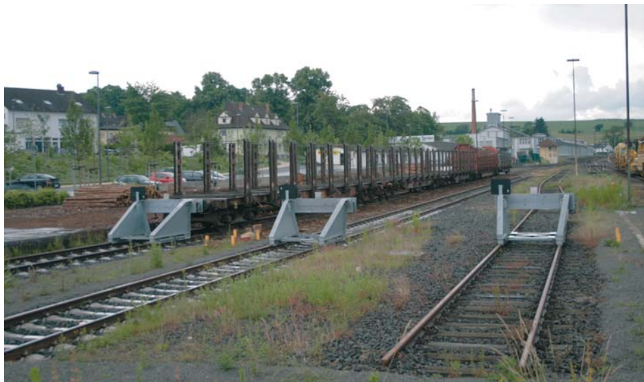
Holzverladung an der neu gebauten Ladestraße im Bahnhof Frankenberg/Eder am 12. Juni 2016.
