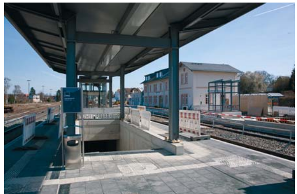
Der neue Inselbahnsteig Gleis 2/4 in Hungen
