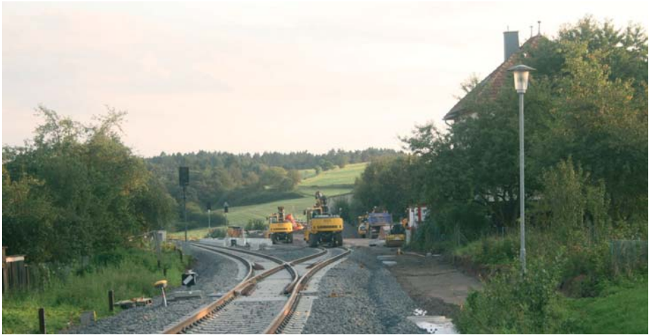
Am 27. August 2017 sind im Kreuzungsbahnhof Viermünden bereits die Gleise verlegt, die neuen Bahnsteigkanten gesetzt und die Ausfahrtsignale Richtung Frankenberg aufgestellt. Der Blick führt von der nördlichen Einfahrweiche über das ehemalige Empfangsgebäude in Richtung Süden. Foto: Jürgen Schmied
