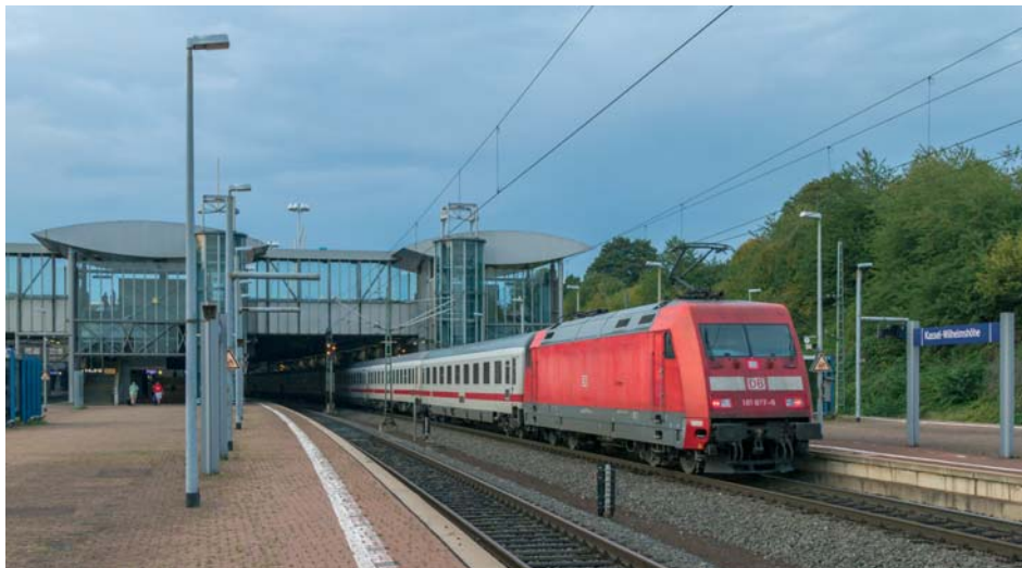
Im Bahnhof Kassel-Wilhelmshöhe wurden mehrere Gleise durch „Hochschottern“ höher gelegt, damit auch die RegioTram-Fahrgäste Ein- und Aussteigen können Foto: Steven Kunz
