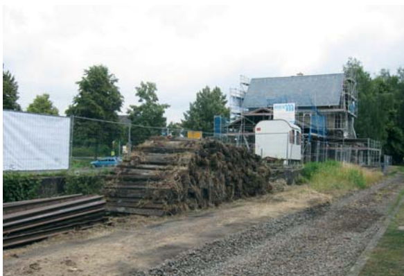
Bahnhof Wölfersheim: Gleis 2 wurde bereits entfernt, das Bahnhofsgebäude ist eingerüstet. Die Modernisierungsmaßnahmen laufen Anfang Juli auf vollen Touren
