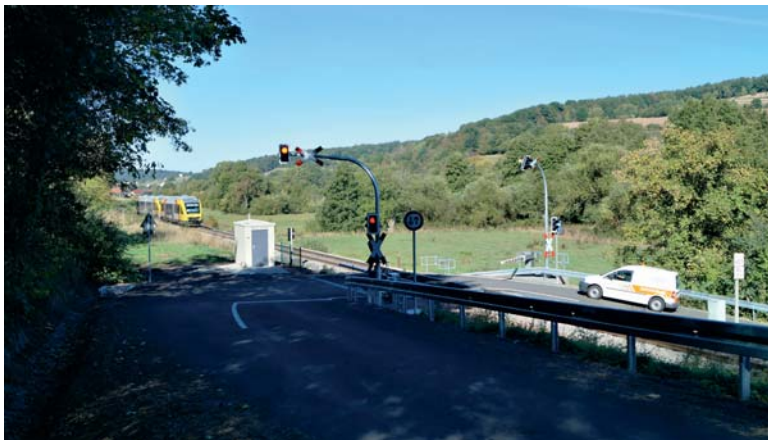
Der neu technisch gesicherte Bahnübergang bei Hetten- hausen entschärft einen Unfall- schwerpunkt
