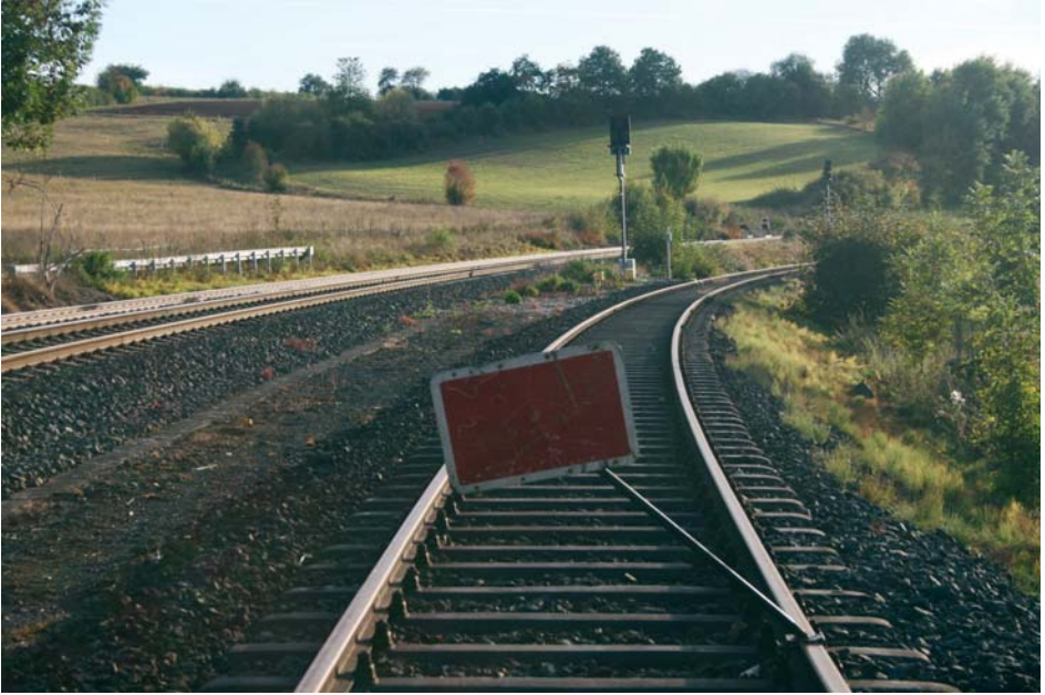
Eine Schutzhaltscheibe versperrt seit Juni 2018 im Bf. Frankenberg/Eder die Ausfahrt auf die Strecke nach Battenberg. Foto: Jürgen Schmied
