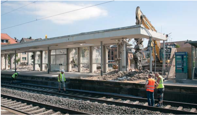
Abriss des Butzbacher Bahnhof- gebäudes am 7. Juli 2018
