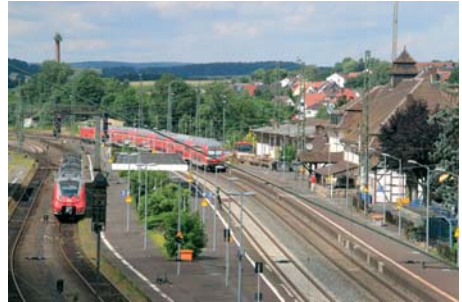
Der Bahnhof Treysa bekommt endlich hohe Bahnsteige Foto: Sören-Helge Zschke
