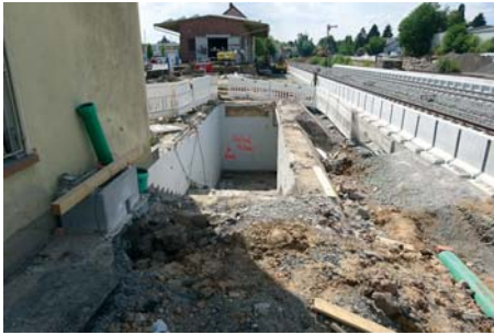
Die Unterführung zu Gleis 2/3 wird ebenfalls erneuert und mit Aufzügen versehen. Rechts die neuen Bahnsteigkanten
