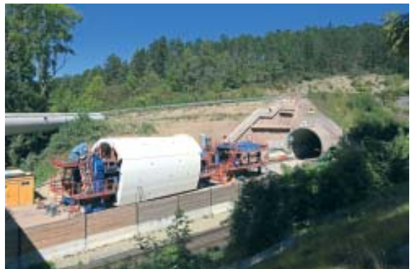
Tunnelportal des neuen Zierenberger Tunnels Foto: Deutsche Bahn AG/ Uwe Miethe
