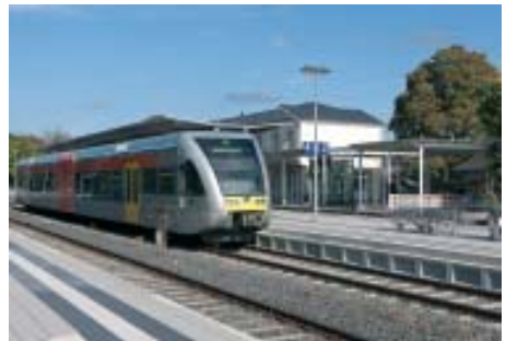
Im Bahnhof Nidda entsteht an Freitagen und Samstagen um 23 Uhr ein neuer Anschlussknoten in alle Richtungen
