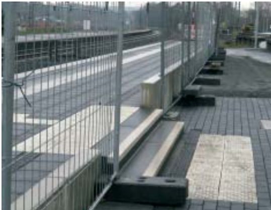
Links der angehobene Bahnsteig, rechts das alte Niveau. An der Betonmauer werden noch Geländer angebracht
