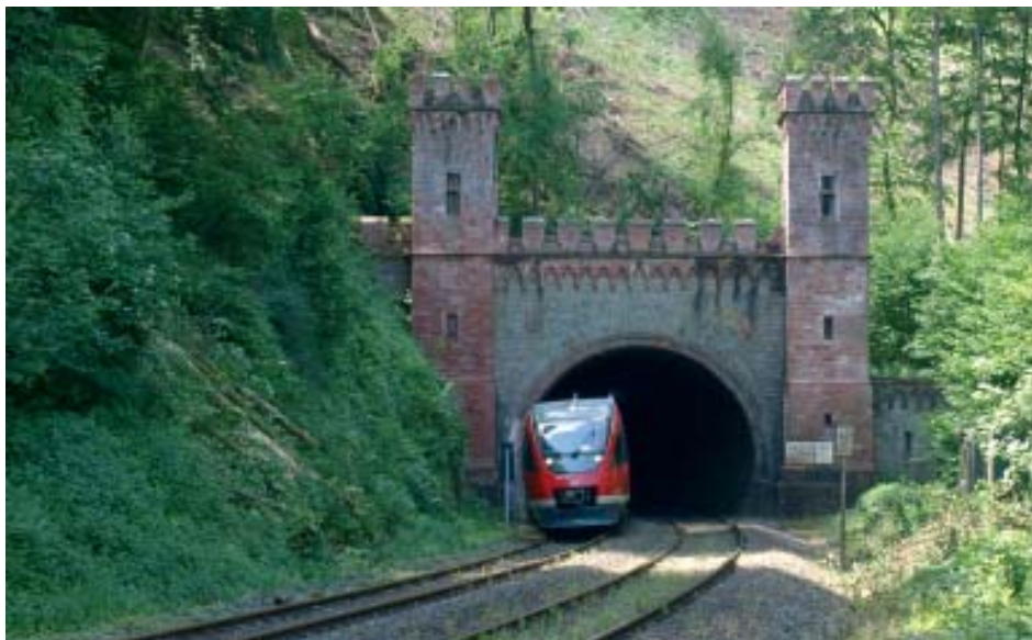
Das Ostportal des Cramberger Tunnels mit seinen Türmen und den Zinnen aus Sandstein steht unter Denkmalschutz, allerdings wird der Tunnelquerschnitt deutlich größer, sodass der Abriss genehmigt und ein in der Anmutung vergleichbarer Neubau errichtet werden muss. Foto: Günther
