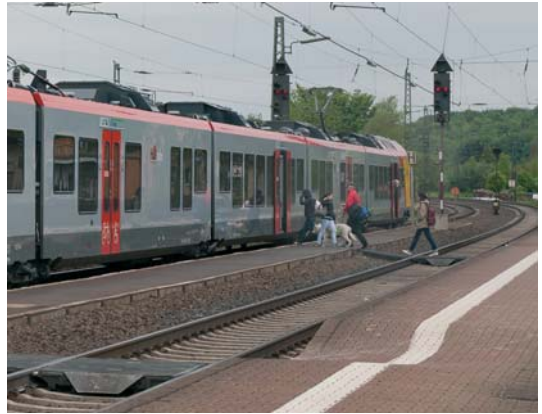
Bahnhof Niederwalgern: Zugang zum Bahnsteig über das Nachbargleis, niedrige Bahnsteige und hoher Einstieg sind nicht mehr zeitgemäß
