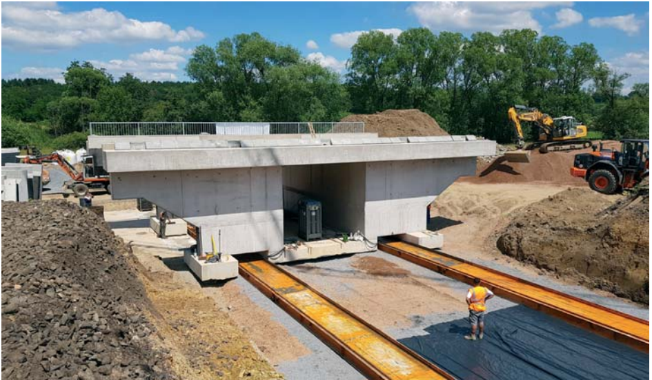
Frei schwebend auf einem dünnen Film aus Stickstoff gelangte die 504 Tonnen schwere Eisenbahnbrücke an ihren vorgesehenen Platz im Bahndamm bei Eschhofen. Foto: Günther
