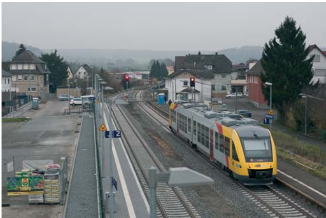
Am Bahnhof Reiskirchen fiel durch einen Blitzeinschlag am 5. Juni 2019 das Stellwerk aus.
