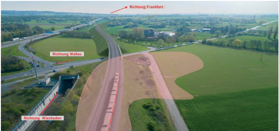
Computeranimation im Bereich des künftigen Haltes Wiesbaden-Delkenheim in Dammlage (schraffierte Fläche) mit Blickrichtung nach Osten. Links im Bild das Portal des bestehenden Tunnels Wandersmann Süd (Länge 776m) zur Unterfahrung der A66 (links oben im Bild). Quelle: Deutsche Bahn
