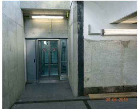
Oben: Zugang zum neuen Aufzug Unten: Der neu gestaltete Hausbahnsteig Fotos: Horst Lorenz
