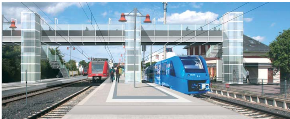
So stellen sich die Planer den Bahnhof Usingen zukünftig vor: Am gleichen Bahnsteig kann von der S-Bahn auf die Wasserstoff-Triebwagen der Taunusbahn umgestiegen werden. Beide Bahnsteige werden über eine große Fußgängerbrücke mit Treppen und Aufzügen angebunden. Das Gewerbegebiet südlich des Bahnhofs wird erstmalig mit einem Zugang links an die Fußgängerbrücke angebunden. Computersimulation: Schüßler-Plan
