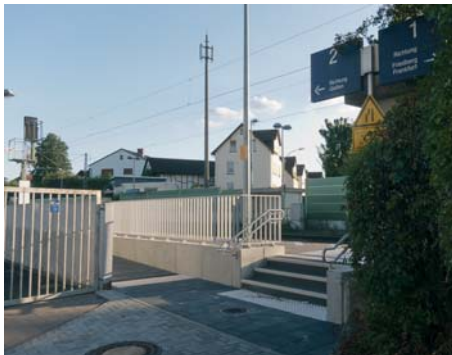
Neue Rampe und Treppe am Haltepunkt Ostheim
