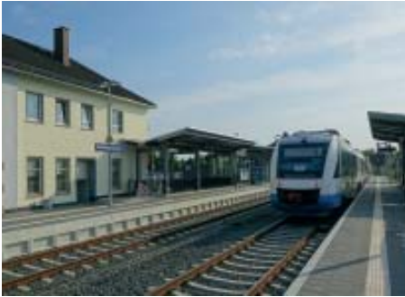
Die Restarbeiten am Bahnhof Grünberg verzögern sich weiter Foto: Horst Lorenz
