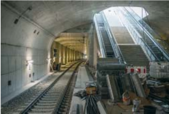
Anfang November 2019 waren an der neuen Station Gateway Gardens noch einige Arbeiten zur Inbetriebnahme zu erledigen Foto: RMV, Christof Mattes
