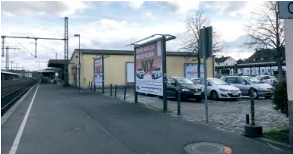
Blick vom Hausbahnsteig des Bahnhofs Fulda nach Süden. Rechts der Busbahnhof, welcher erweitert werden soll. Dazu sollen die Gebäude im Vordergrund abgerissen werden. Dort könnte auch das Gleis der Rhönbahn enden. Fotos: Pro Bahn & Bus Osthessen
