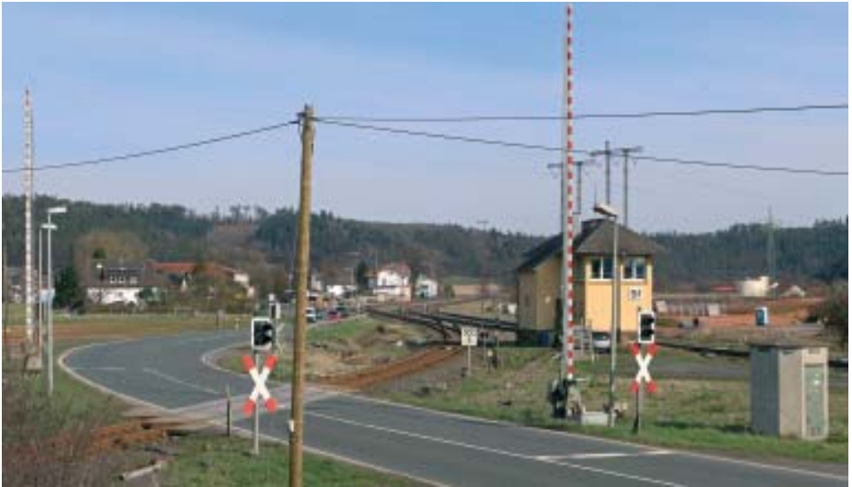
Blick aus Richtung Westen auf den Bahnhof Sarnau, in Bildmitte das ehemalige Bahnhofsgebäude. Das Gleis Richtung Frankenberg (links) soll einen größeren Radius bekommen, so dass schneller ein- und ausgefahren werden kann.
