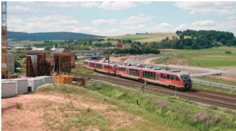
Eine Triebwagen-Doppereinheit der Baureihe 642 der Kurhessenbahn passiert als RB 94 das Stellwerk in Sarnau, welches bereits Anfang Juli abgerissen wird. Das Stellwerk Sf versteckt sich hinter der Einschulung für den Brückenpfeiler der Umgehungsstraße. Etwa 30 Meter neben dem Gleisbogen der Burgwaldbahn ist bereits das Gleis auf der neuen Trasse verlegt. Die Strecke wird im Zuge der Bauarbeiten verschwenkt. Foto (21. Juni 2020): Stefan Tripp
