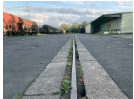
Die Laufschiene des alten Containerkrans
