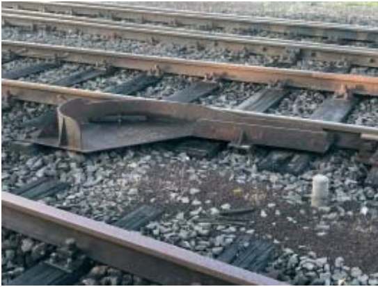
Am Ablaufberg rosten die Hemmschuh-Auswerfer vor sich hin Sechs Fotos: PB&B Osthessen
