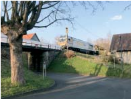
Ein Bauzug mit der Diesellok V500.06 der SGL SchienenGüterLogistik in Lütter (Einfahrt aus Richtung Gersfeld)
