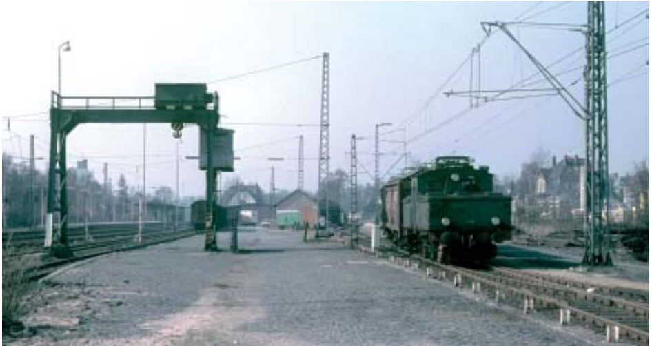
Oberursel: Der Güterbahnhof der Stadtwerke Frankfurt war mit einem Gleisdreieck an die Stadtbahnlinie U3 angeschlossen. Rechts der Privatbahnteil, links die DB-Gleise, im Hintergrund das DB-Bahnhofsgebäude. Rechts entsteht jetzt die neue Abstellanlage Foto (26. März 1982): Andreas Christopher
