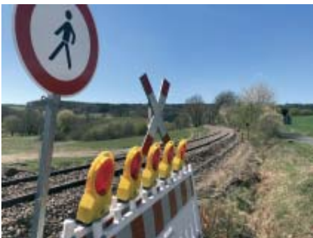
Rhönbahn: Saniertes Gleis zwischen Schmalnau und Ried 2 Fotos: PB&B Osthessen
