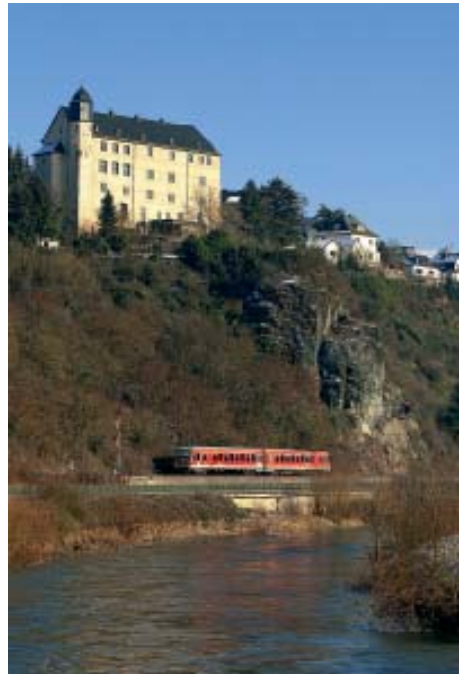
Auch das mechanische Einfahrtsignal unter Burg Schadeck wird durch ein elektrisches ersetzt
