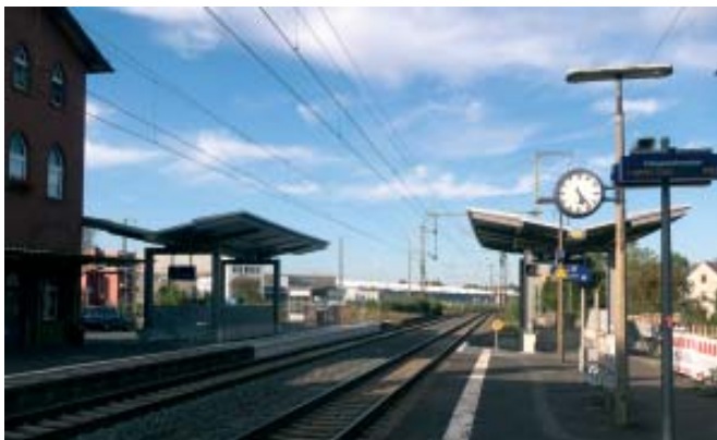
Neue Überdachungen über der Fußgängerunterführung. Nächstes Jahr werden auch die Bahnsteige modernisiert
