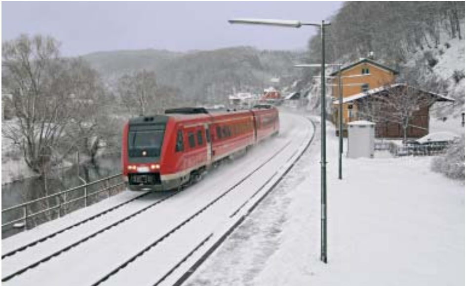
In Aumenau werden in Zukunft alle Personenzüge am Hausbahnsteig halten. Auf der Lahnseite (links) ist kein Platz für einen zusätzlichen Bahnsteig 2 Fotos: Ronny Köppel
