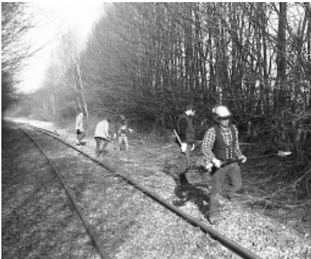
Im Bahnhof Flacht konnte die Strecke mit professionellem Gerät weitgehend profilfrei geschnitten werden. Das anfallende Schnittgut wird von den Bauhöfen der an der Strecke liegenden Gemeinden entsorgt.
