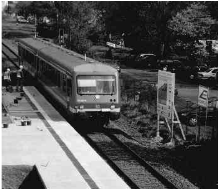
Blick von der Fußgängerbrücke auf den neuen Haltepunkt 3 Fotos: Michael Marinc
