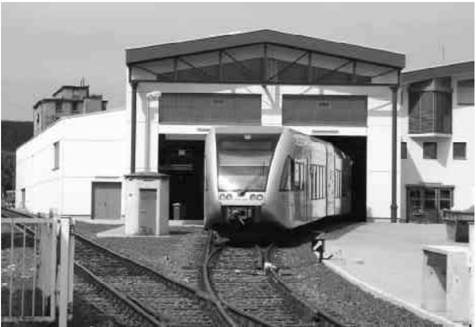
Die neue Betriebswerkstatt in Butzbach-Ost
