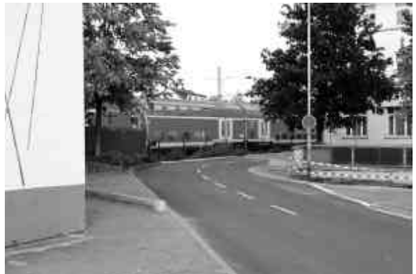
Die jetzt doppelspurige Ludwigstraße. Links der Zugang zu Gleis 1. Fahrgäste, die von dort kommen, stehen fast unvermittelt auf der Straße
