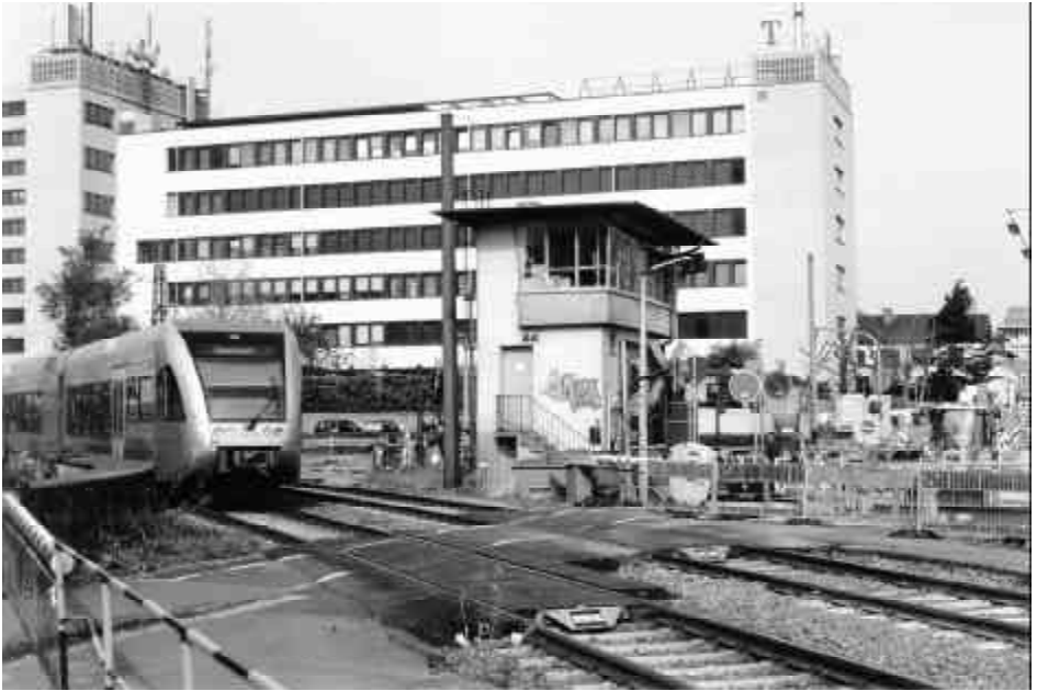
Der Schrankenposten in Gießen an der Frankfurter Straße wurde zwischenzeitlich abgerissen Foto: Friedrich Lang
