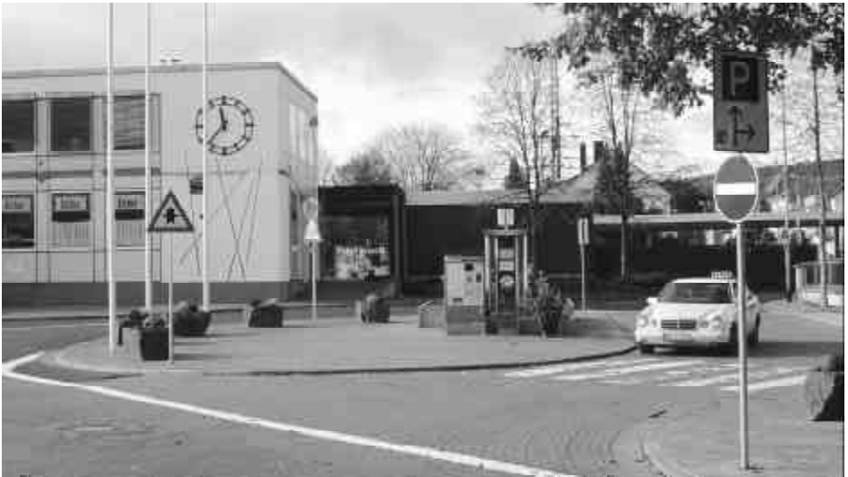
Rechts die alte Straßenführung, die jetzt als Taxistand ohne jeden Wetterschutz dient. Auf der Insel in der Mitte der ebenfalls allen Wettern ausgesetzte RMV-Automat und das Münztelefon. Ein Zebrastreifen zum Bahnhof links fehlt, aber genug Geld für Fahnenstangen und sonstige Fahrbahnmarkierungen war noch da
