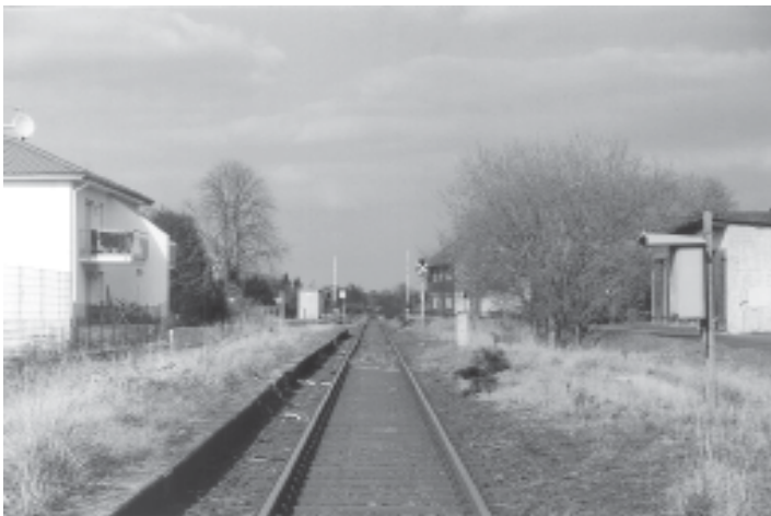
Die Bahnsteigkante in Asbach. Das Bahnhofsgebäude wurde abgerissen. An seiner Stelle steht jetzt links ein neues Wohnhaus.
