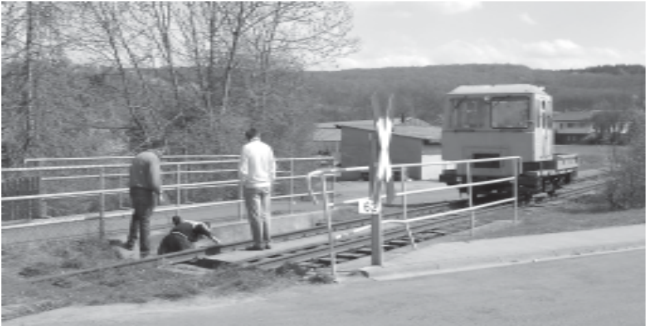
Am 18. April 2004 untersuchten die Eisenbahnfreunde Wetterau mit Hilfe eines Sachverständigen alle Brücken und Durchlässe. Das Bild entstand am Bahnhof Oppershofen
