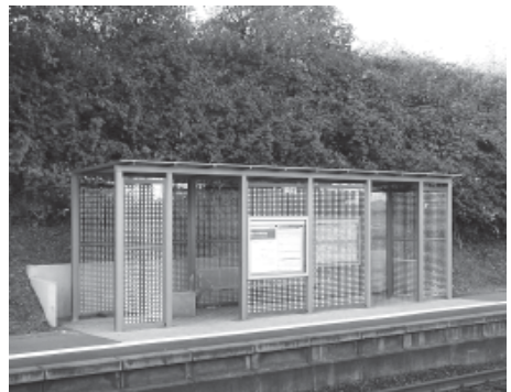
Eine neue Warteinsel am Bahnhof Bruchenbrücken Foto: Lars Kühnemund
