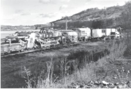
Bei Braunfels ist ein Bauzug auf der Lahntalbahn im Einsatz. Foto: Friedrich Lang
