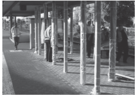
Montage der neuen Unterstellmöglichkeiten im Bahnhof Butzbach
