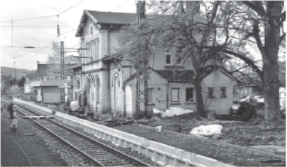
Der Bahnhof Gensungen-Felsberg erhält neue Bahnsteige Foto: Friedrich Lang
