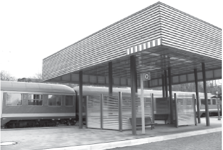
Die neue Halle im Bahnhof Grebenstein, die sowohl Bus- wie Bahnfahrergäste dient Foto: 45b MEDIENDESIGN
