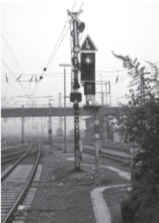
Generationswechsel am Gleis 9 in Gießen: Hinten das alte Formsignal außer Betrieb, vorne das neue KS-Signal
