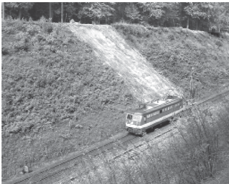
Die Hangrutschstelle zwischen Kirch-Göns und Butzbach im Griedeler Wald
