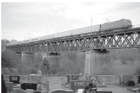
Umgeleiteter Intercity nach Frankfurt auf der Talbrücke bei Assenheim
