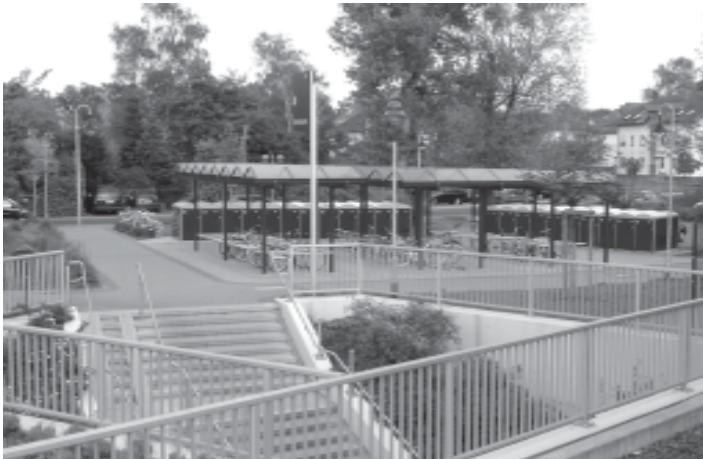
Bei den Bahnhofsumbauten wurden auch gute Abstellmöglichkeiten für Fahrräder geschaffen. Im Bild die überdachten Abstellplätze in Obertshausen, teilweise mit Fahrradboxen
