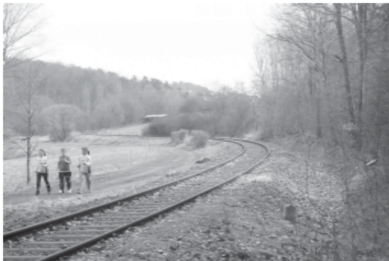
Sauber freigeschnittener Streckenabschnitt der Lumdatabahn unterhalb von Trais
