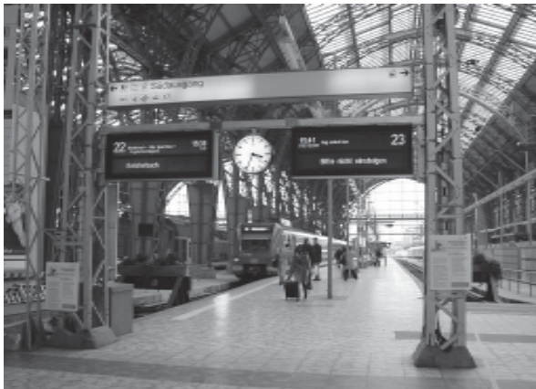
Die neuen Anzeigetafeln in Betrieb an Gleis 22/23 im Frankfurter Hauptbahnhof
