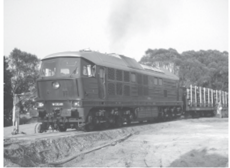
Die Teerdecke fehlt bereits, als der letzte Holzzug vor dem Umbau die Baustelle passiert
