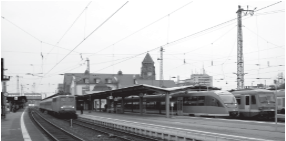
Der Bahnhof Gießen erhält eine komplett neue Bahnstufenunterführung . Foto (22.02.2006): J. Lerch
