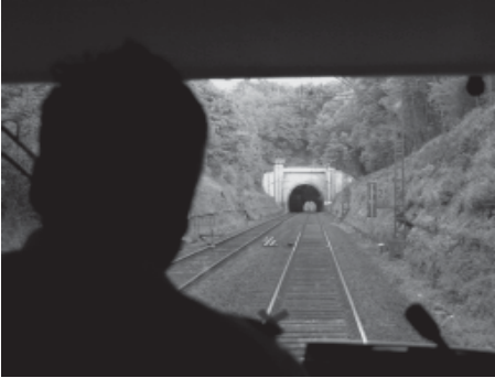
Bei Probefahrten nach Melsungen wird der Guxhagener Tunnel durchfahren
