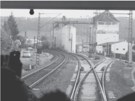
Die Einfahrt in den Gleisstumpf Melsungen-Süd. Hier soll später auch noch ein Haltepunkt errichtet werden
