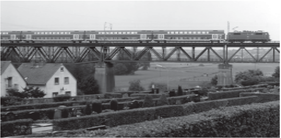
Nur bei Umleitungen verkehren auch Doppelstockzüge über die Assenheimer Brücke Foto: Andreas Christopher
