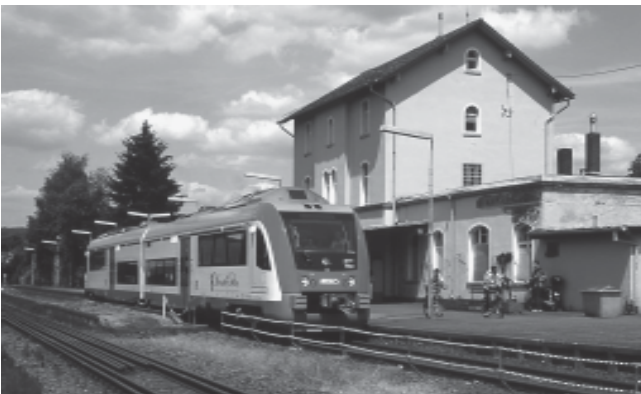
In Bad König haben die Bauarbeiten für den neuen Bahnsteig begonnen
