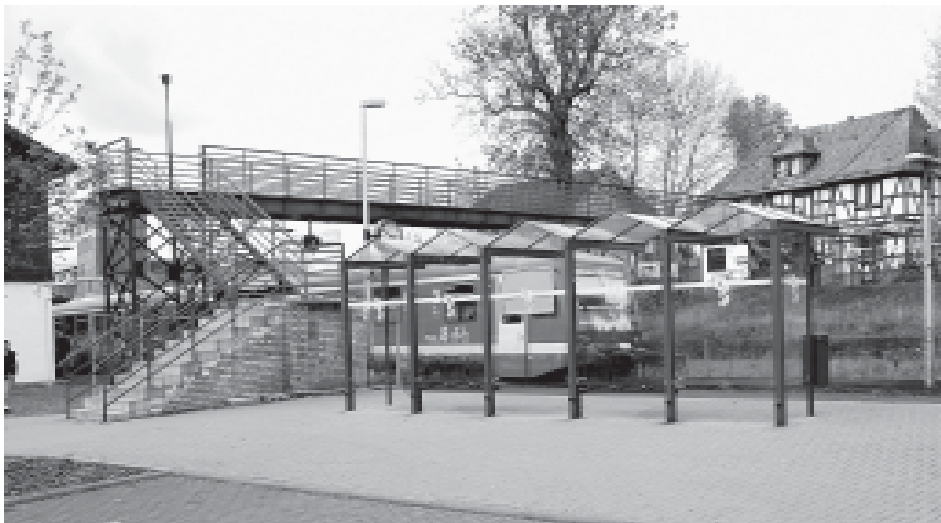
Die alte Fußgängerbrücke am Mücker Bahnhof soll abgerissen und durch einen Neubau ersetzt werden
