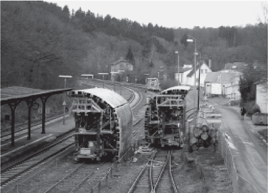
Im Bahnhof Kerkerbach werden die Schalwagen für ihre Wochenendeinsätze vorbereitet. Der zu sanierende Ennericher Tunnel befindet sich am Ende der oben sichtbaren Bahnhofsausfahrt
