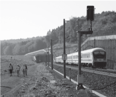
Intercity auf der Strecke Hamm - Kassel am Eggetunnel
