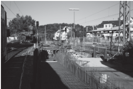
Die Unterführung im Bau im September 2006
