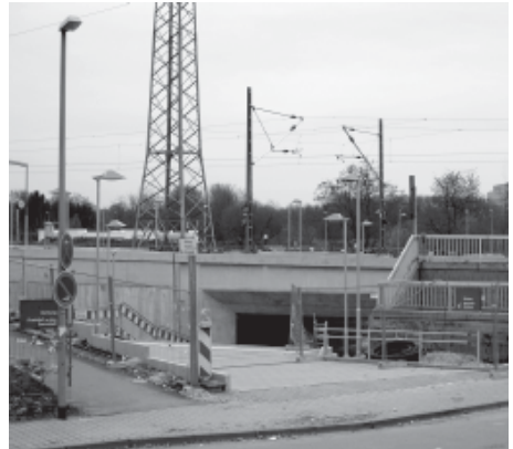
Die neue Fußgängerunterführung kann bereits genutzt werden
