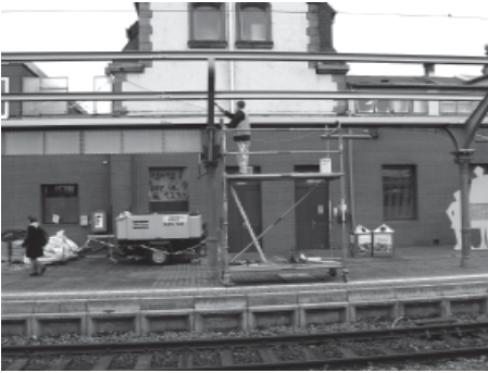
Auch das Dach am Bahnsteig 1 wird erneuert
