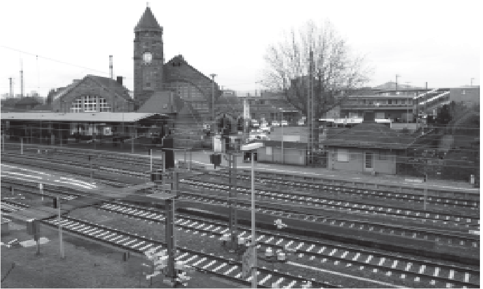
Im oberhessischen Teil des Gießener Bahnhofs sollen die Bahnsteige erneuert werden 3 Fotos: Friedrich Lang
