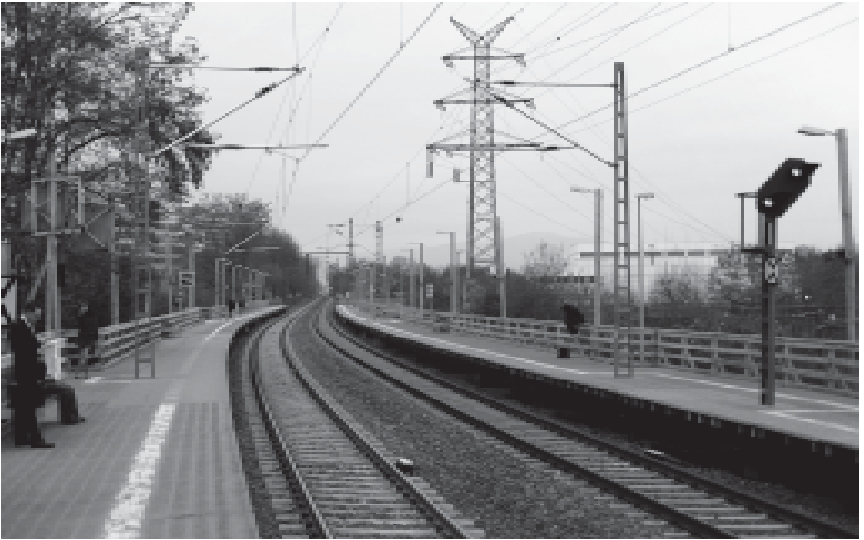
Mit erheblichem Aufwand wurden zwei provisorische Bahnsteige Richtung Eschborn errichtet
