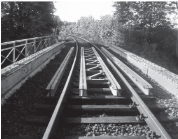
In die im letzten Jahr durch einen LKW beschädigte Brücke wurde eine Kleinhilfsbrücke eingesetzt
