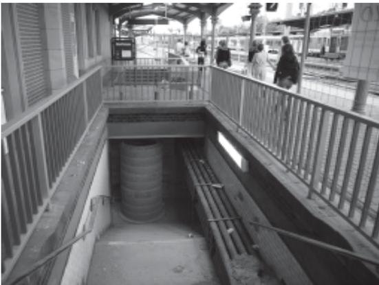
*...während auf der Seite der Main-Weser-Bahn in der alten Unterführung Versorgungsleitungen und Betonrohre installiert wurden*
