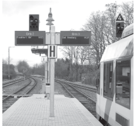
Die Zugzielanzeiger auf den Bahnsteigen funktionieren mittlerweile ohne Probleme
