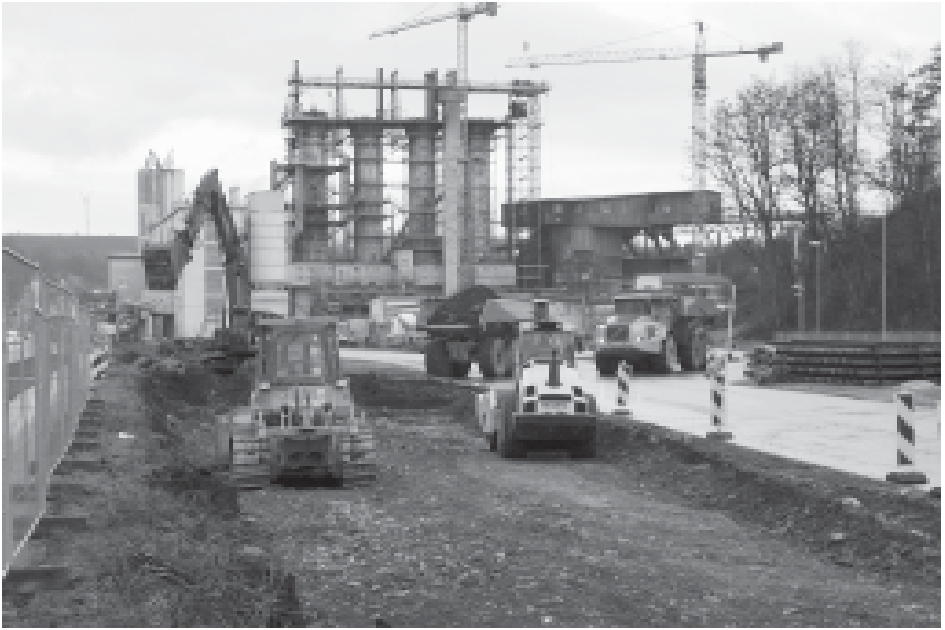
Kalkwerk Steeden: Die Arbeiten für drei neue Brennöfen und das Gleisplanum sind im Gang Foto: Hans-Peter Günther
