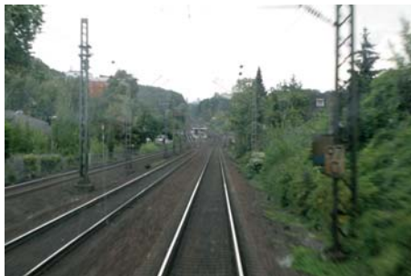
Auf der Steilrampe hinunter nach Erkrath. Der Bahnsteig liegt in der Waagrechten, direkt davor hört das Gefälle auf
