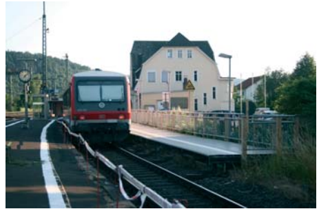
Provisorischer Bahnsteig im Bahnhof Cölbe Foto: Jürgen Schmied
