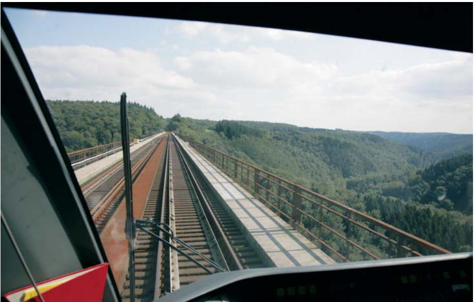
Blick aus dem Führerstand auf die Müngstener Brücke und das Wuppertal
