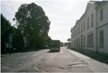
Der Bahnhofsvorplatz in Nidda kann mit den neuen Bahnsteiganlagen nicht mithalten und bedarf der dringenden Modernisierung auf einen zeitgemäßen Standard
