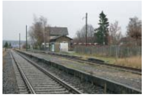
Der Bahnhof Reichelsheim soll 2010 einen neuen Mittelbahnsteig erhalten, so dass die maroden Bahnsteigkanten dann verschwinden
