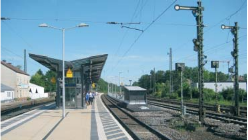
Links der erneuerte Hauptbahnsteig, rechts der bei Zugüberholungen genutzte Bahnsteig, der aus Mitteln des Konjunkturprogramms ebenfalls hergerichtet wurde Foto: Lars Kühnemund
