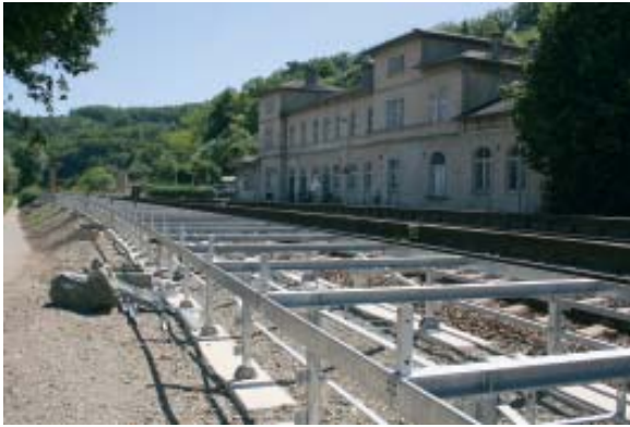
Die Stahlkonstruktion für den neuen Außenbahnsteig am Bahnhof Braunkopf
