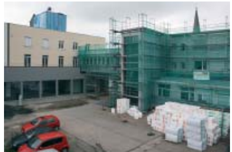
Sanierung Bahnhof Limburg: Die RMV Mobilitätszentrale befindet sich jetzt im modernen Anbau neben dem Bahnhof (links im Bild)
