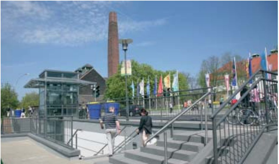
Der Aufgang zum Eingang der Landesgartenschau wurde komplett neu gestaltet. Im Hintergrund das ehemalige E-Werk und die alte Wäscherei, in der Ausstellungen zur LGS stattfinden
