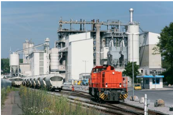
Wurde mit Landesmitteln gefördert: Gleisanschluss zum Kalkwerk Steeden
