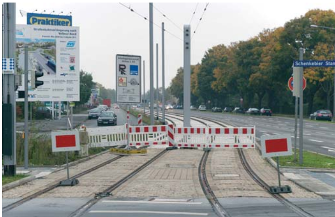
Der Gleisbau an der Wendeschleife Holländische Straße ist abgeschlossen
