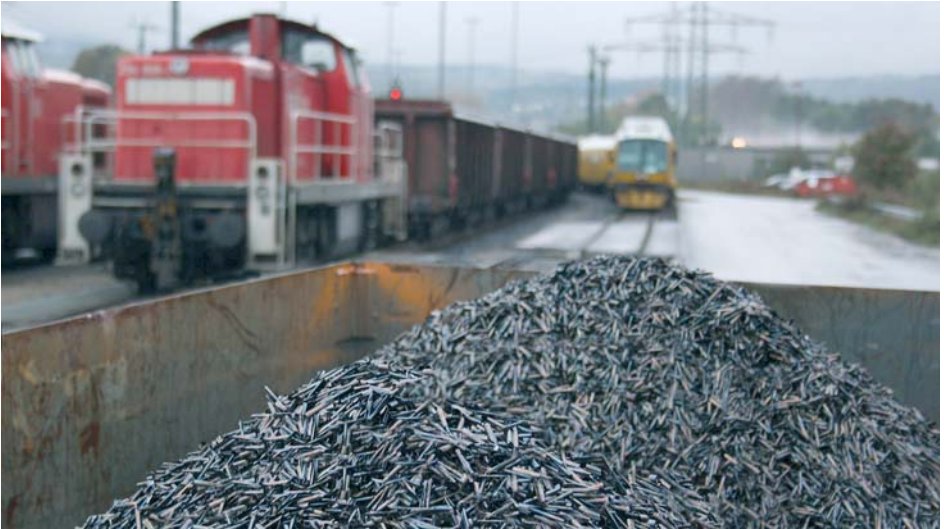
Da das Schleifen der Schienen nicht ausreicht um die feinen Rissbildungen zu beseitigen, sind die Schienen bereits mehrfach abgefräst worden. Die Späne müssen abgesaugt und entsorgt werden, damit sie keine Schäden an den ICE-Zügen anrichten. Foto: Günther
