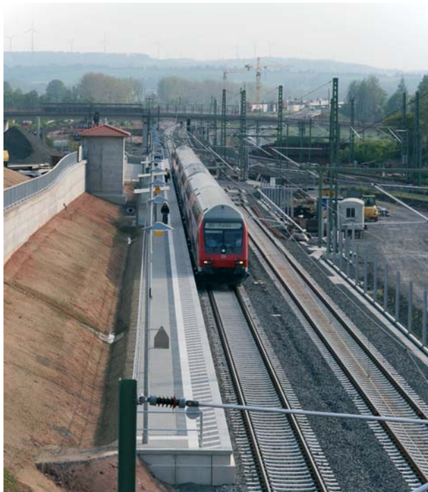
Einfahrt des RE Frankfurt (Main) – Fulda an den neuen Bahnsteig des Bahnhofs Neuhof; rechts das noch nicht fertig gestellte Hauptgleis Fulda-Frankfurt (Main); links die Außenwand des Autobahntunnels der A66.
