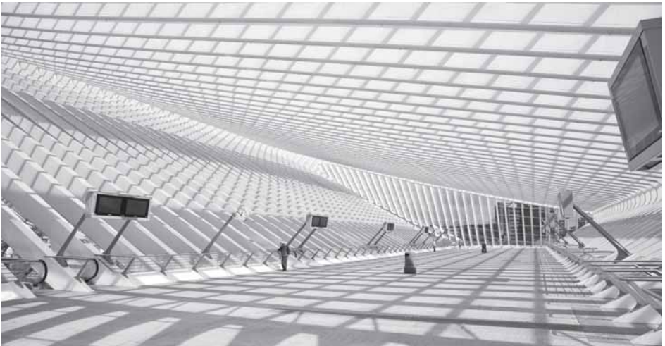
Obere Verteilebene mit den Abgängen zu den Gleisen
