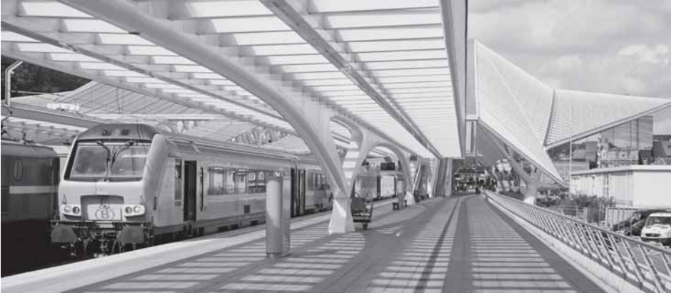
Bahnsteig Gleis 1: Die normale Bahnsteigüberdachung geht in die Bahnhofshalle über
