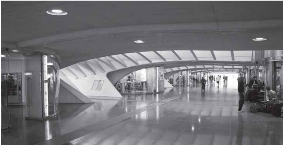
In die Bahnstufunterführung fällt natürliches Licht von oben durch Glasbausteine ein, die im Boden der Bahnsteige eingelassen sind. Links und rechts sind Geschäfte für den Reisebedarf untergebracht
