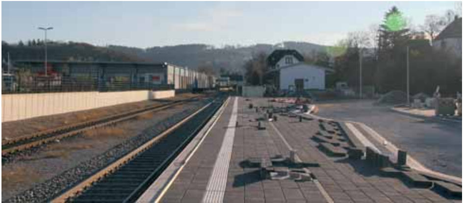
Der neue Stadtbahnhof in Brilon Mitte November: Der kombinierte Bahn-/Bussteig ermöglicht kurze Umsteigewege. Im Hintergrund der alte Bahnhof 2 Fotos: Thomas Lütke
