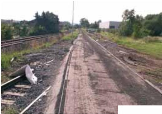
*Zugepflasterter Gleisanschluss zum Industriegebiet Welkers*
