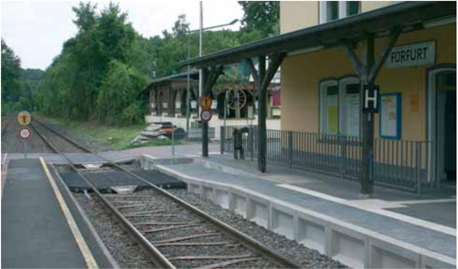
*Offenbar auf Anweisung des EBA senkte die DB Anfang Juni sieben gerade erst neu gesetzte Kantsteine ab und verschob den Überweg an das Bahnsteigende. Die neu montierte H-Tafel soll verhindern, dass ein Fahrgastwechsel im abgesenkten Bereich stattfindet. 2 Fotos: H.-P. Günther*
