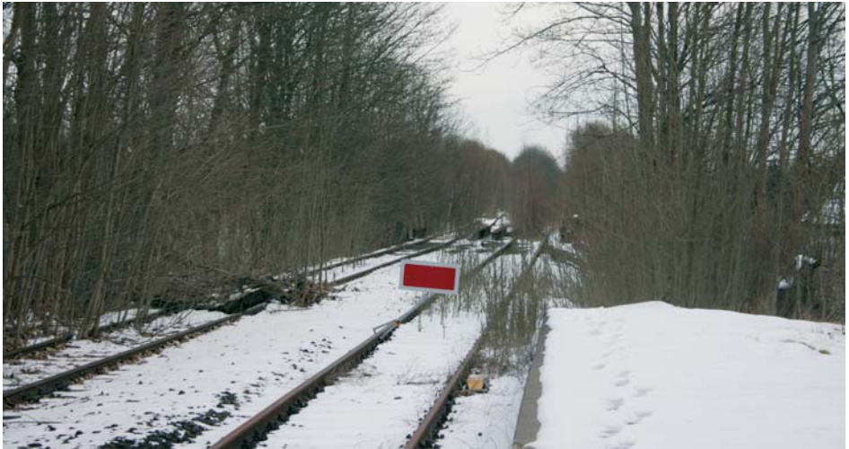
In anderthalb Jahren wird man von Korbach-Süd aus wieder auf dem rechten Gleis zum Edersee und nach Frankenberg fahren können. Links das ehemalige Streckengleis der stillgelegten Strecke nach Bad Wildungen Foto: Martin Böhm
