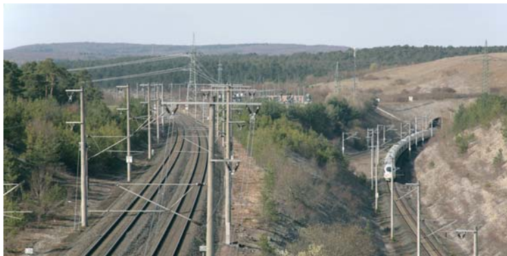
Abzweigstelle Rohr bach: Links die Schnellfahr- strecke Würzburg - Fulda, rechts die Nantenbacher Kurve, welche nach wenigen Kilometern auf die Altstrecke Würzburg - Frankfurt mündet
