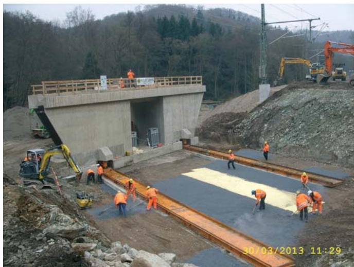
Ein Luftpolster und acht Lastmodule ließen die neue Brücke über die orangefarbenen Gleitbahnen in ihre neue Position schweben.
