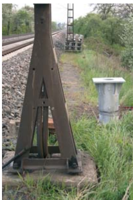
Neue Kabelkanäle und SignalfüÙe werden im Zuge des ESTW-Aufbaus gesetzt
