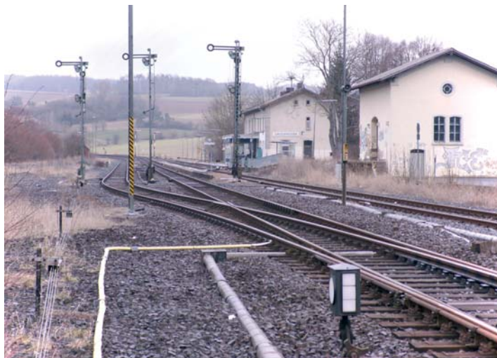
Das Gleis 3 im Bahnhof Großlüder (links) soll rückgebaut werden.
