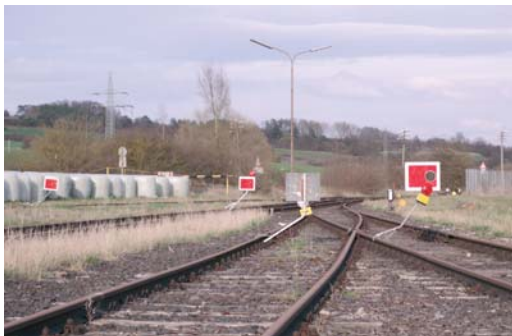
Die Industriegleisanlage zu Otterbein ist gesperrt – Holzverladungen können nicht mehr stattfinden
