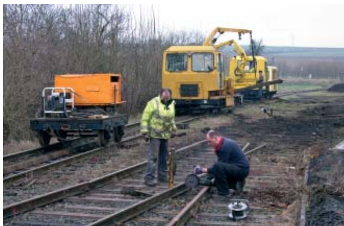
Gleisbauarbeiten der Eisenbahnfreunde Wetterau im Dezember 2012 in Griedel
