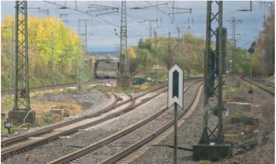
Südausfahrt des Bahnhof Friedberg: Rechts das Streckengleis Richtung Friedrichsdorf, in der Mitte die beiden Gleise führen nach Frankfurt. Unter der Brücke hindurch liegen die Gleise nach Hanau. Im Bau ist eine neue Gleisverbindung in Bildmitte. Zuerst sind aber noch Oberleitungsarbeiten notwendig
