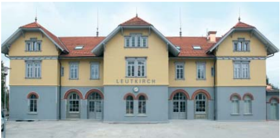
Der Bürgerbahnhof in Leutkirch Foto: Leutkircher Bürger-Bahnhof eG
