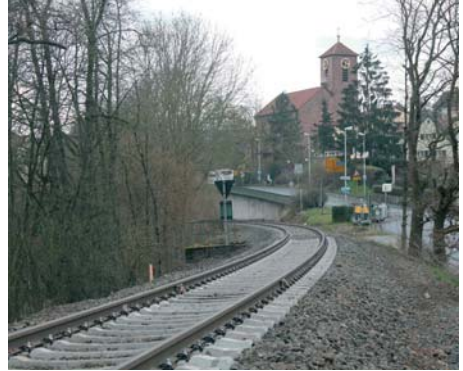
Der im März 2014 erneuerte Oberbau in Lohr
