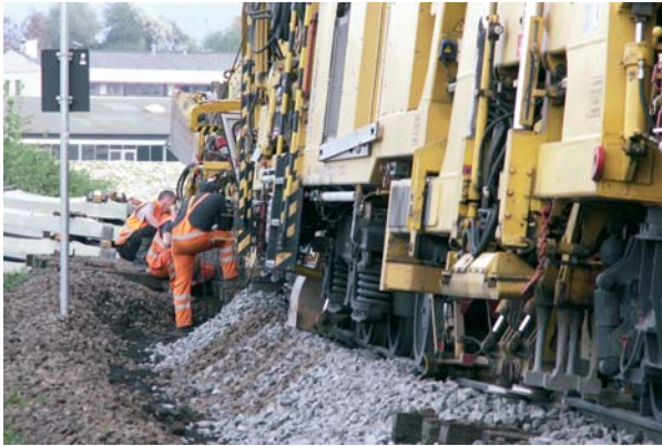
Bei Bauarbeiten in Großenlüder wurde im Streckengleis eine Weiche zum ehemaligen Anschluss Durawerke entfernt. Foto: Stefan Sitzmann
