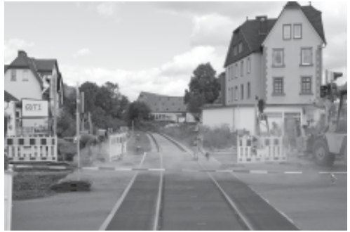
Arbeiten am neuen Bahnübergang in Frankenberg, Röddenauer Straße
