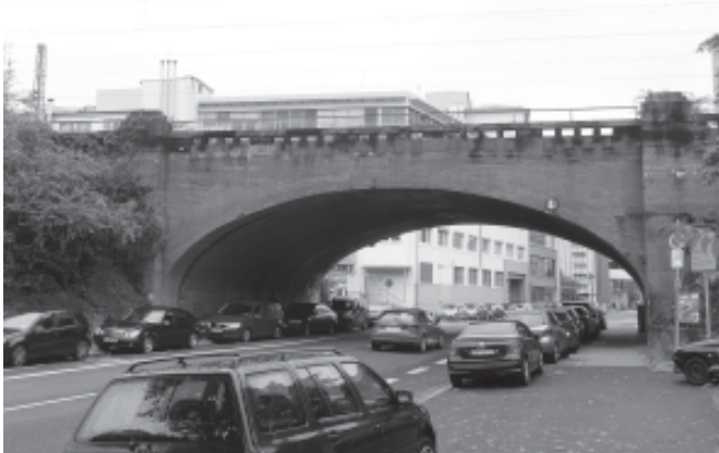
Blick auf den Homburger Damm im Bereich Kleyerstraße. Um den nördlichen Teil des Hauptbahnhofs besser anzubinden, soll ein zusätzliches Gleis gebaut werden
