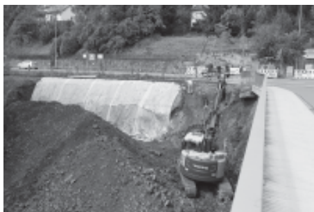
Arbeiten in Frankenberg-Goßberg
