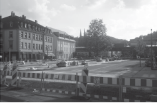
Blick vom Empfangsgebäude auf die Baustelle des Bahnhofsvorplatzes in Marburg. Die Bushaltestelle in Insellage ist bereits gepflastert. Foto: Jürgen Schmied
