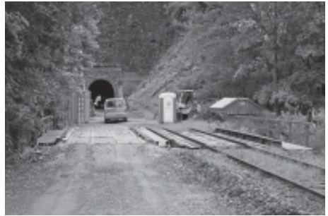
Großer Ittertunnel: Auch hier laufen die Instandsetzungsarbeiten
