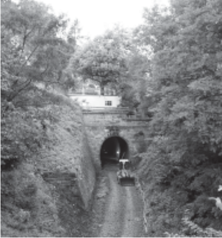
Bauarbeiten im kleinen Ittertunnel. Die Gleise wurden wegen der Bauarbeiten entfernt
