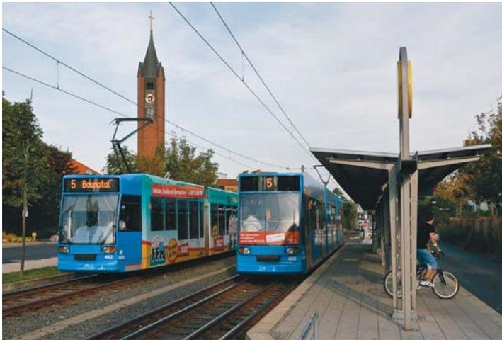
*In Baunatal-Mitte ist gut die aufwändige Gleiskonstruktion erkennbar, die dazu dient, Eisenbahnfahrzeuge und schmalere Straßenbahnen auf einer Trasse entlang des Bahnsteigs fahren zu lassen.*
